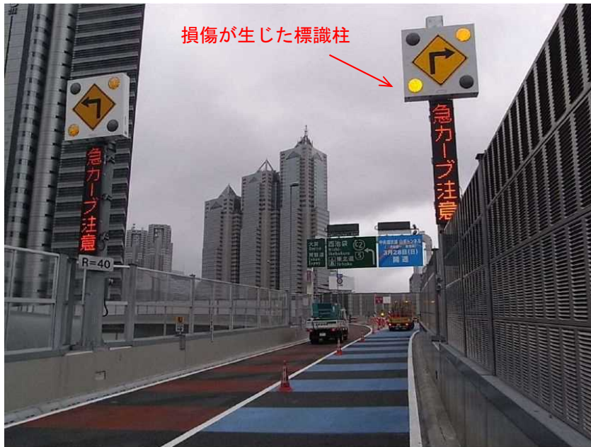
写真-1.5 左右の標識柱の違い
