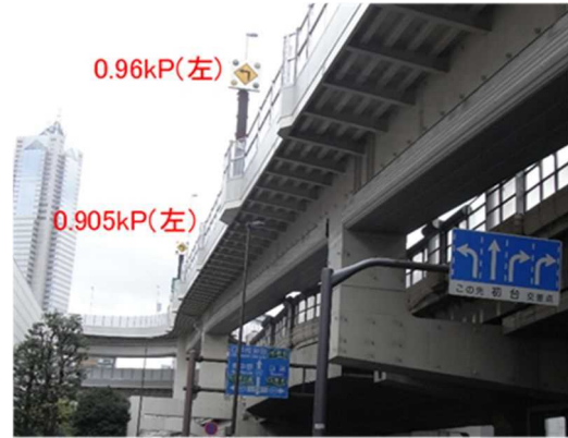
図-1.8 西新宿 JCT 付近の標識柱の設置位置
