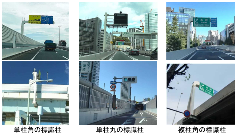
写真-3.3 標識柱の構造形式の例
