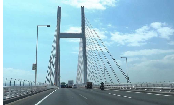
(2) 横浜ベイブリッジ付近に設置された STBG12-17.45P
