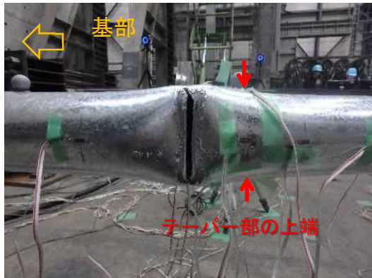
図-4.19 テーパー部分の上端付近に発生した亀裂
