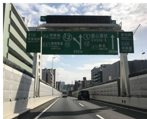
写真-2.2 門型標識柱
