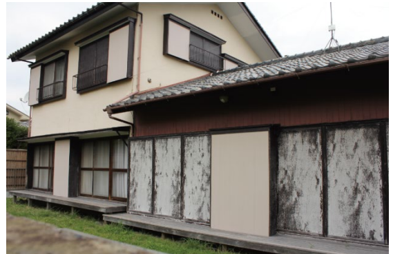
写真2 掃き出し窓が多い事例
