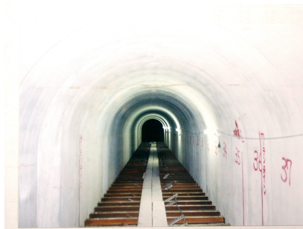
写真-6.1.3 プレキャスト型枠設置後の状況
