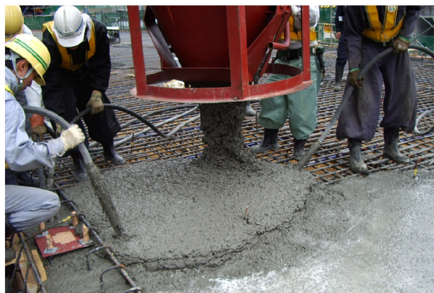
写真-6.2.19 上床版の打込み状況
