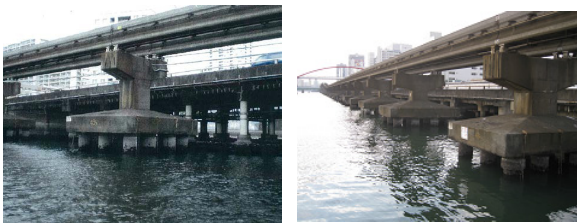
写真-6.2.10 工事着手前の構造物
