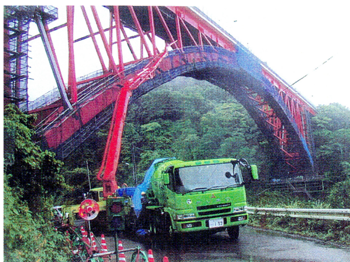
写真-6.2.6 圧送状況①（橋下の道路からの圧送）
