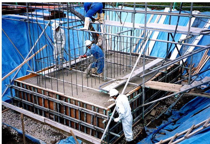
写真-4.2.13 A1フーチングの施工状況
