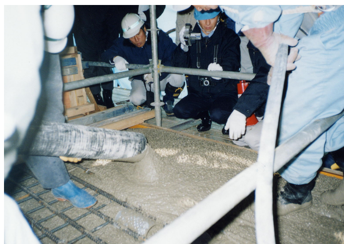
写真-4.2.8 下床版の打込み・締固め状況
