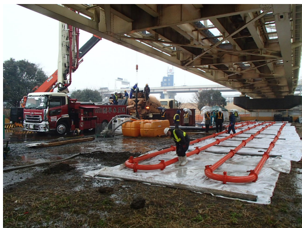
写真-6.2.16 圧送実験の状況
