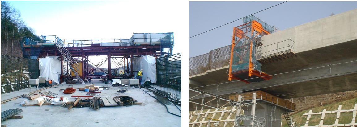
写真-6.1.12 壁高欄の移動式型枠
