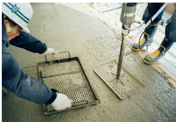
写真-4.2.9 上床版の仕上げ状況（ジッターバッグ 14) による荒ならし・押さえ）
