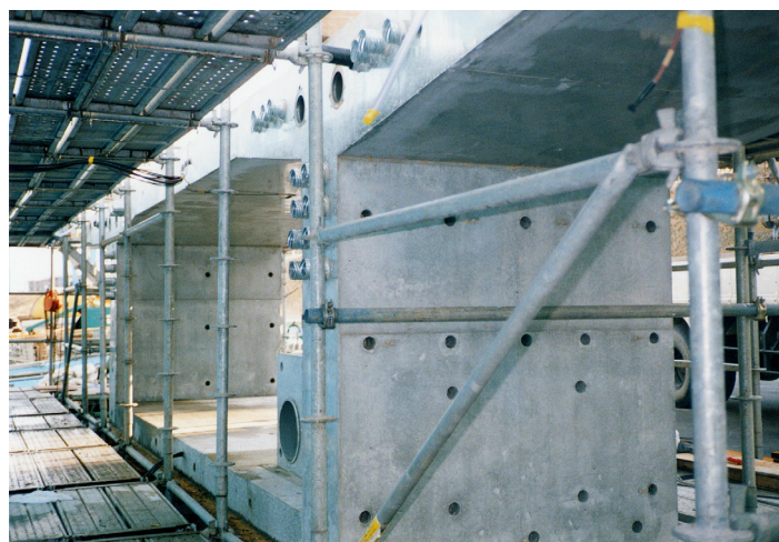
写真-4.2.10 セグメントの出来形
