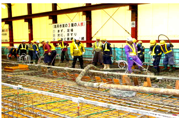
写真-6.1.10 製作台内でのコンクリートの打込み状況
