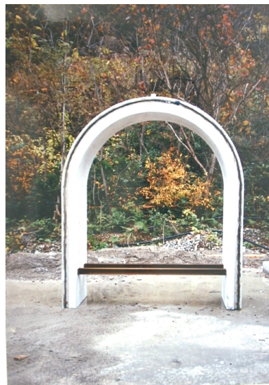
写真-6.1.2 プレキャスト型枠
