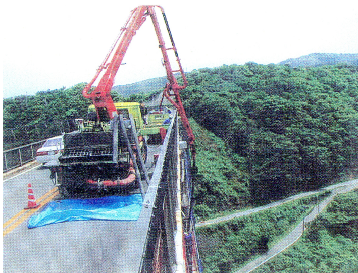
写真-6.2.7 圧送状況②（橋面からの圧送）
