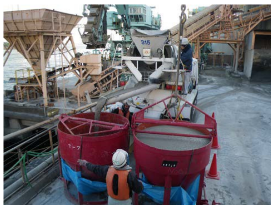
写真-6.2.12 アジテータ車からバケツへの荷卸し状況
