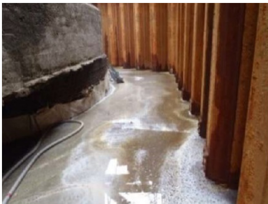
写真-6.2.18 ドライアップ後のコンクリート上面の状況
