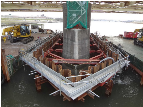
写真-6.2.17 コンクリートの打込み状況
