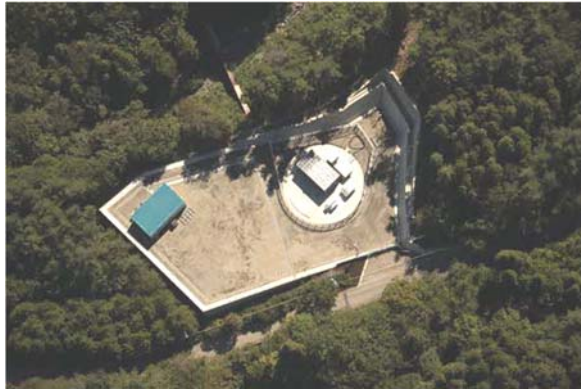
図-2.2.4 換気・避難を目的とする枝坑坑口が地上に至る部分
