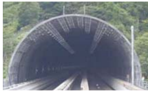
写真-5.1.1 多孔板緩衝工
