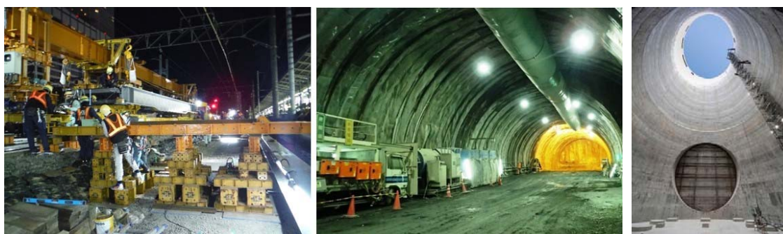
図-1.2.5 工事の写真(左:名古屋駅における工事桁の架設,中央:南アルプストンネルにおける本線トンネルの掘削,右:都市部の立坑の底部から非常口を見上げた状況)
