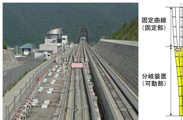
図-2.2.3 山梨実験線の明かり区間の分岐器
