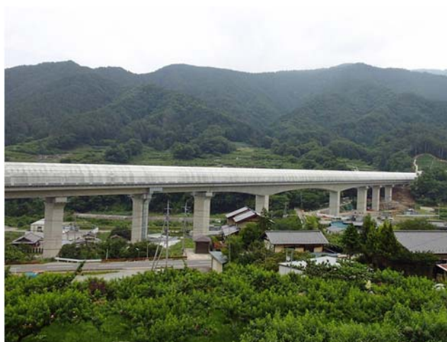
図-1.3.1 防音防災フードの例(山梨実験線)
