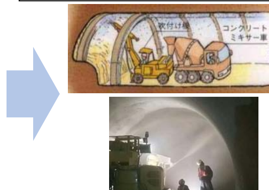
図-4.3.1 NATM による施工手順 (イラスト 1) は一部修正・加筆)
