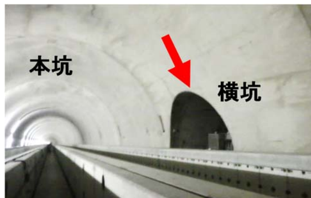
図-2.2.2 山梨実験線のトンネル内の横坑
