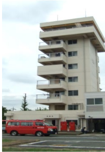
図 2.13 消防活動訓練を実施した 8 階建て中層建屋 (横浜市消防局消防訓練センター内)
