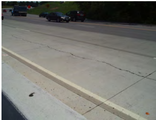
e) Longitudinal cracking
