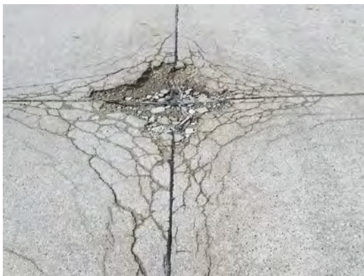
a) D-cracking
