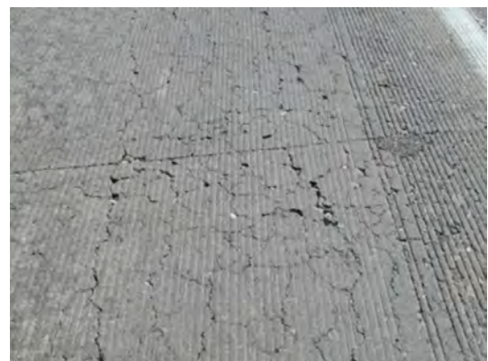
b) ASR cracking
