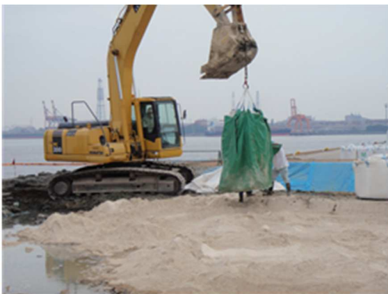
写真 5.2.2-1 防塵カバー使用状況 (Aタイプをバックホウ型で試したケース)
