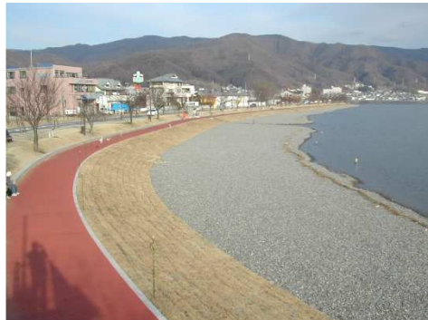
写真 4.3.1-1 湖岸造成の盛土への有効利用 (歩行者道、芝、砂利の下層に改質土を用いる)
