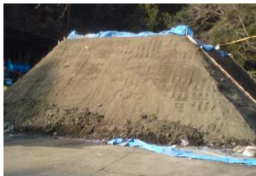
写真 5.2.2-5 PS 灰改良材土の仮設盛土
