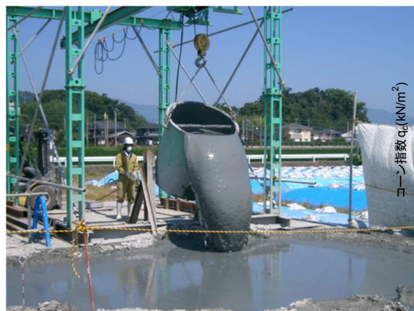
写真 4.5-3 掘削排泥
