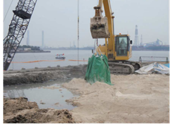
写真 5.2.2-1 防塵カバー使用状況 (Aタイプをバックホウ型で試したケース)
