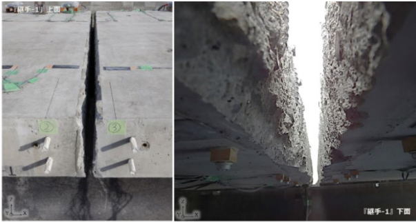
図-6.35 WJ 研り後の継手状況
