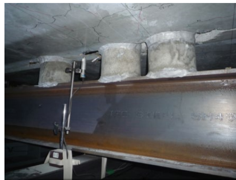
図-6.7 弾性支持梁設置状況
