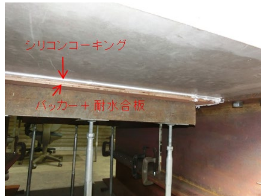
(b) 充填部底面の型枠
