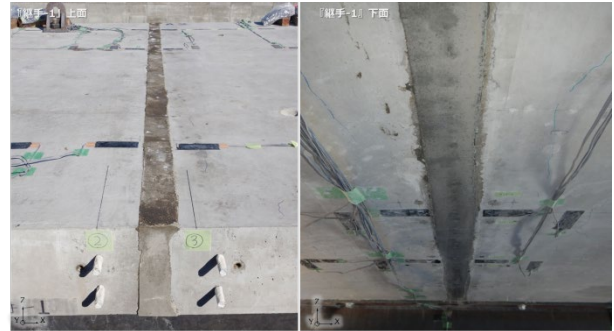
図-6.36 再充填後の継手状況
