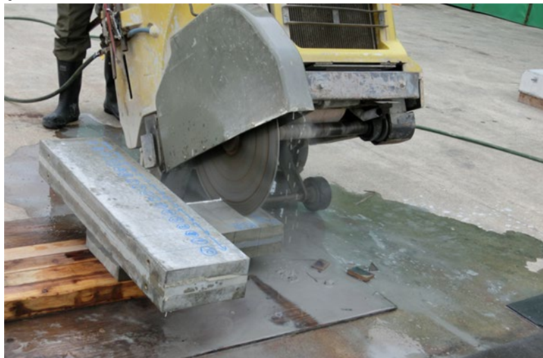
図-7.15 湿式コンクリートによる切断状況
