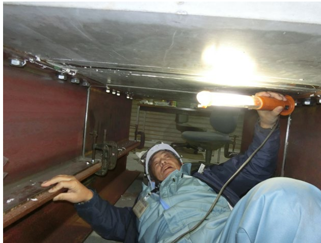
図-7.30 充填材底部のひび割れ発生有無確認状況
