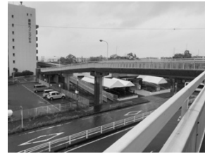
写真1 幹線道路にかかる陸橋
