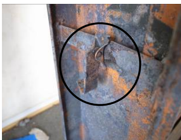
写真 4-21 起倒式アンカー（倒れ状態）
