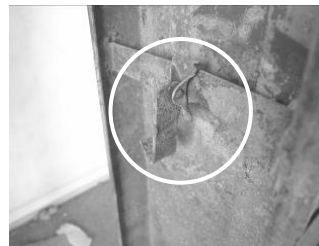
写真8 起倒式アンカー (倒れ状態)
