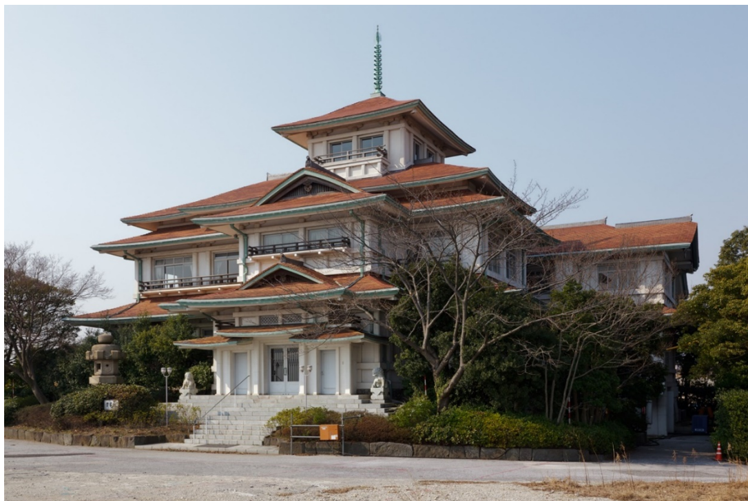
写真 2-1 旧東伏見邦英伯爵別邸（玄関正面側）
