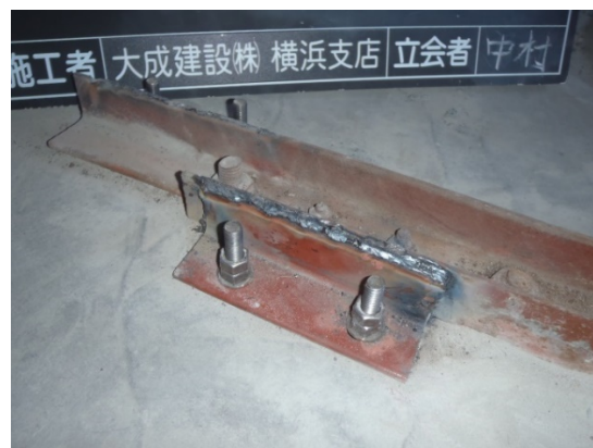
写真 4-45 Lアングル補強状況
