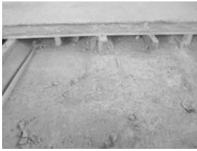
写真 10 1F 床仕上げ撤去
