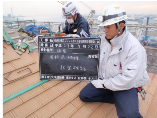
写真 4-33 瓦補修・張替工事状況. 2
