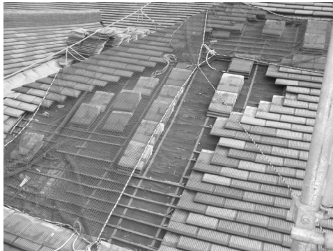
写真2 屋根保存工事状況
