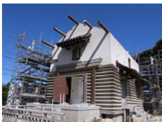
写真 4 屋根の解体中
