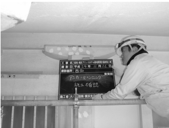
写真 9 アンカーピンニング施工状況
