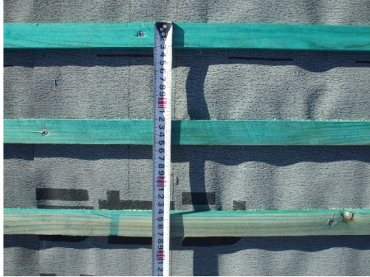
写真 4-38 棧木の取付け状況
