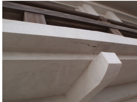
写真 4-20 外壁調査状況 2
