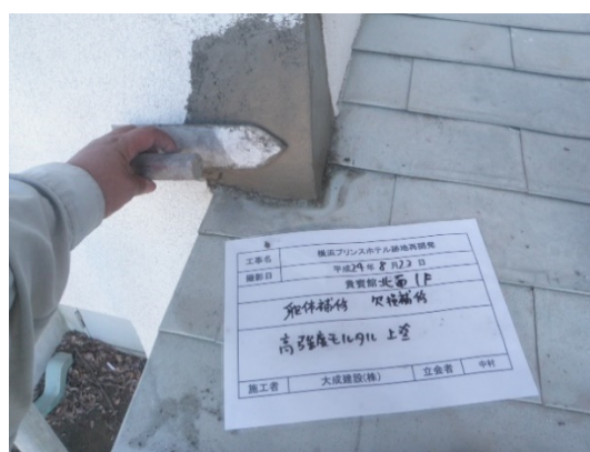
写真 4-53 高強度モルタル塗付状況
