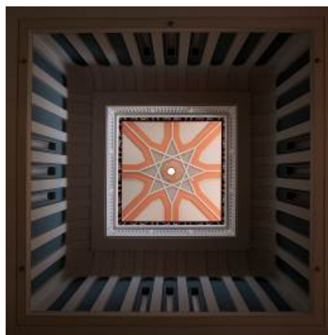
写真 4-14 塔屋の見上げ
