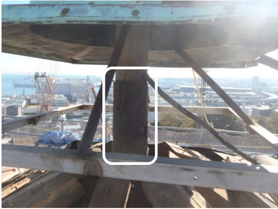
写真 4-40 鋼管腐食部
