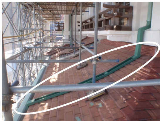
写真 4-63 新規樋の設置状況
