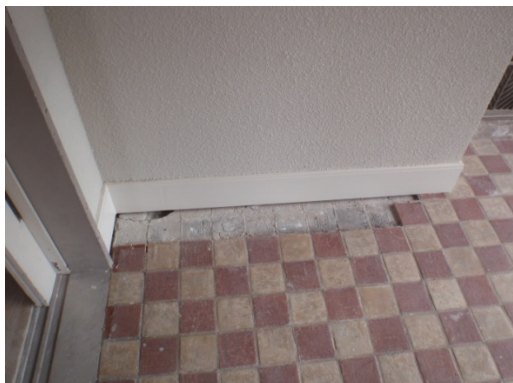
写真 4-66 壁新設部サンプル床タイル
