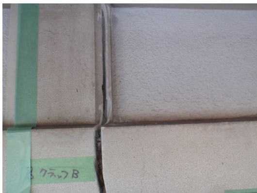
写真 4-48 Uカット溝切り状況
