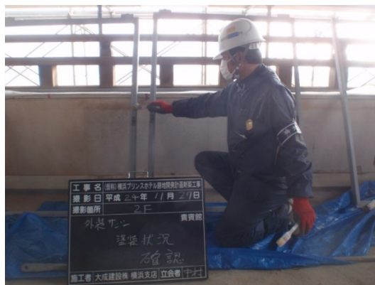
写真 4-59 窓障子部塗装状況
