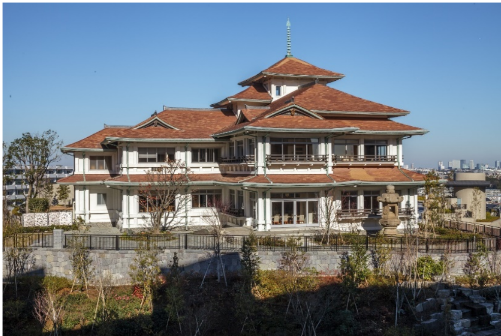
写真4-4 旧東伏見邦英伯爵別邸の外観状況
