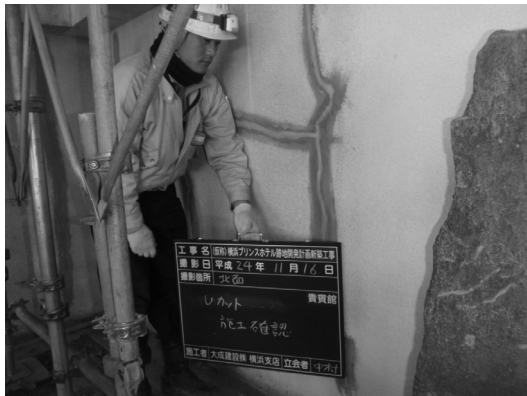
写真 8 Uカット充填状況
