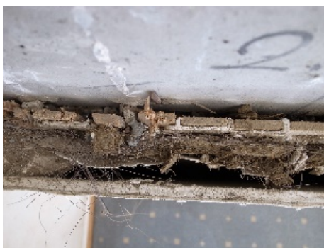
写真 4-24 壁仕上げ撤去状況
