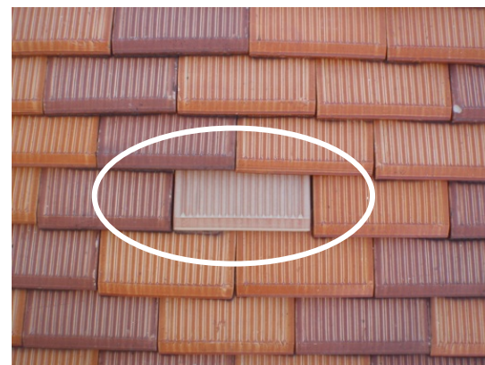
写真 4-35 瓦差し替え後状況
