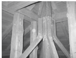
写真6 相輪固定状況
