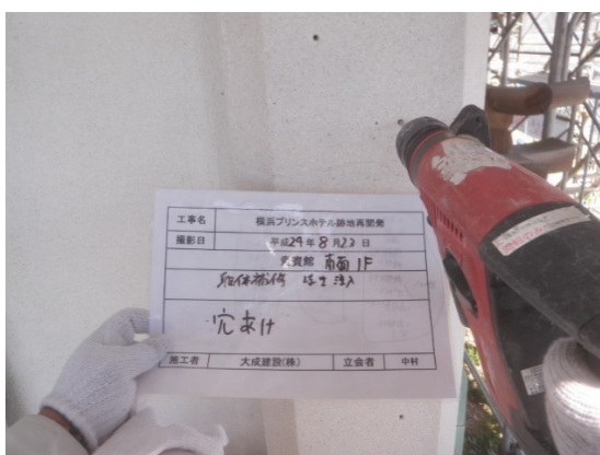
写真 4-50 アンカーピン用穴あけ状況
