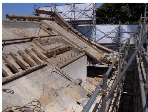
写真 4-29 屋根解体状況
