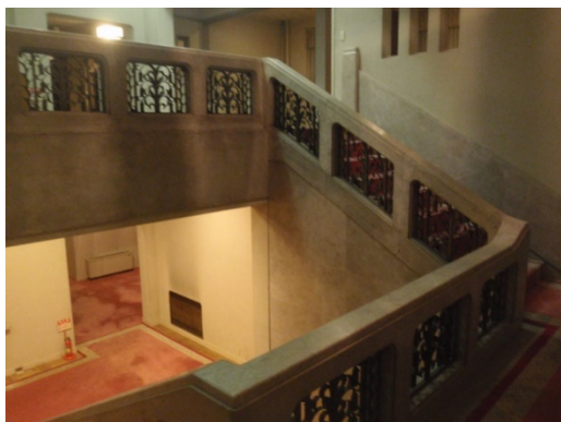
写真 4-70 新設手摺設置前の階段 A
