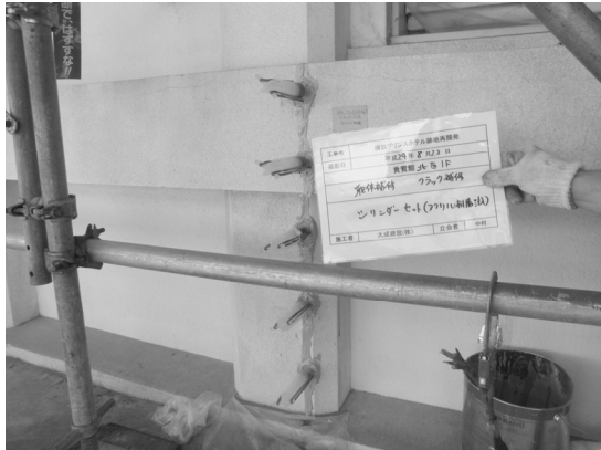
写真 7 アクリル樹脂注入状況
