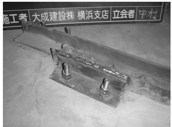
写真6 アンクル補強状況
