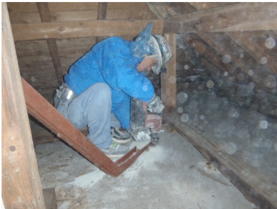
写真 4-44 ケミカルアンカー打設状況
