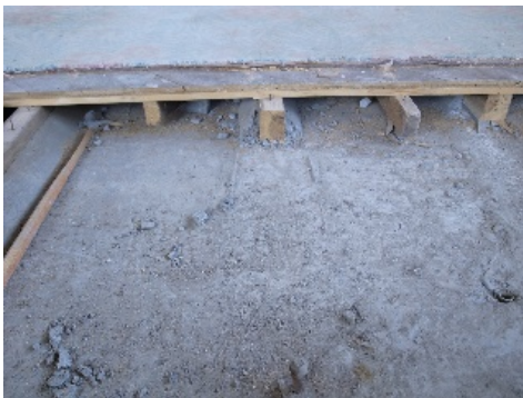
写真 4-23 1F 床仕上げ撤去
