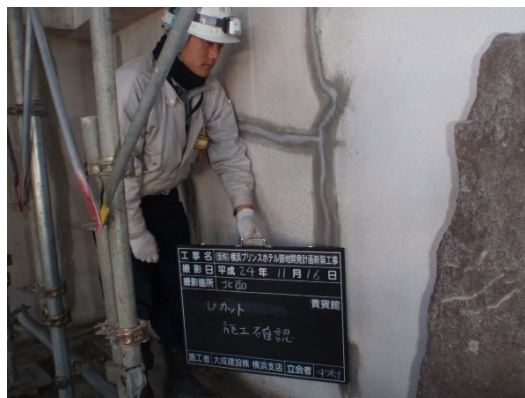
写真 4-49 Uカット充填状況
