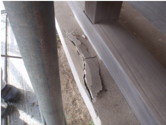
写真 4-19 外壁調査状況 1
