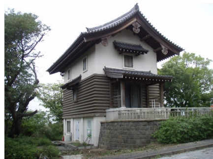
写真 4-15 解体前の蔵の外観
