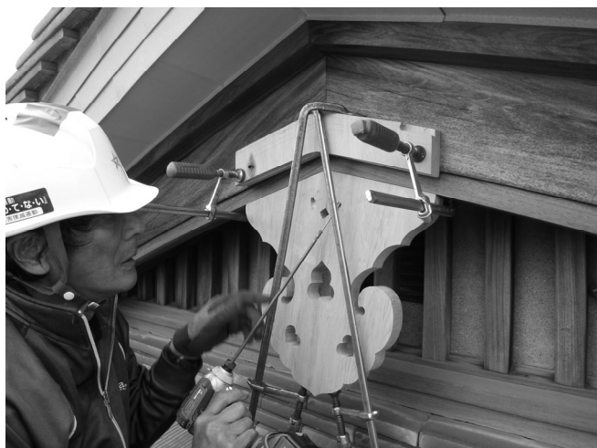
写真 12 懸魚補修状況
