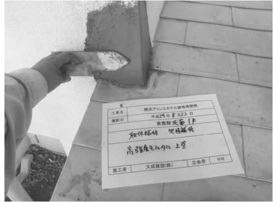
写真 10 高強度モルタル施工状況
