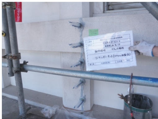
写真 4-47 アクリル樹脂注入状況
