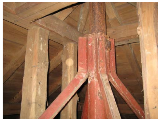
写真 4-18 相輪固定状況
