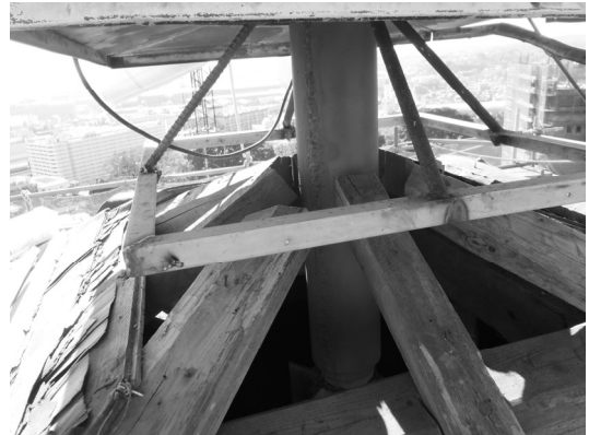
写真5 補強鋼管取付状況
