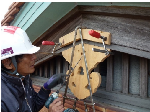
写真 4-60 懸魚補修状況
