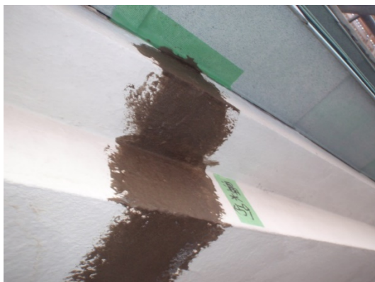
写真 4-54 漏水部補修処置状況
