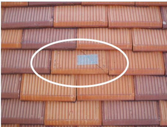
写真 4-34 瓦差し替え前状況
