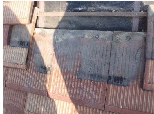
写真 4-17 庇屋根部分の瓦下調査状況
