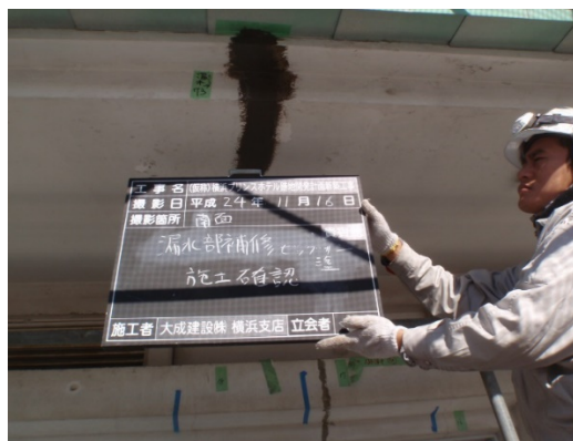
写真 4-55 漏水部補修処置状況
