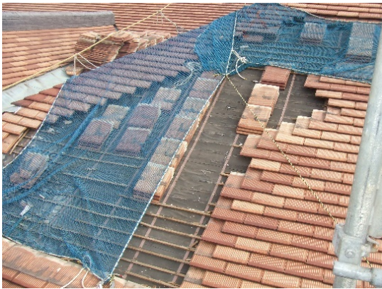
写真 4-32 瓦補修・張替工事状況. 1
