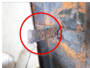
写真4 起倒式アンカー (起こした状態)
