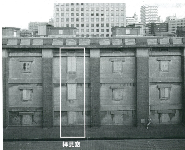
写真7 B号倉庫解体前外観写真(拝見窓)
