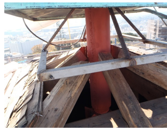
写真 4-43 補強鋼管取付け状況
