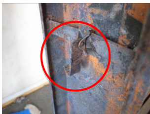
写真3 起倒式アンカー (倒れた状態)
