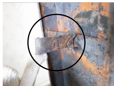
写真 4-22 起倒式アンカー（起こした状態）
