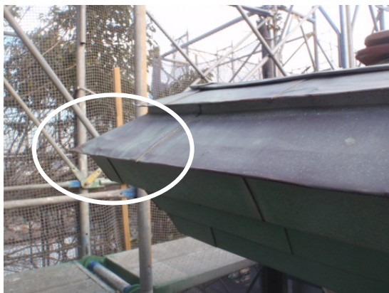
写真 4-62 軒先部分補修状況
