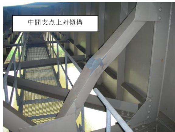
図-1.5 中間支点上対傾構の損傷事例 50)
