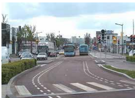
図 3-12 Rouen のガイドウェイ区間 ( CIVIS : 白線検知システム )
