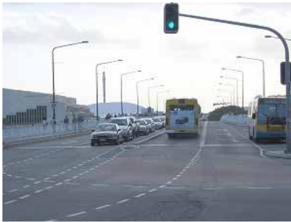
図 4-8 4 車線道路（橋梁）のうち 2 車線をバス専用道路に再配分した例
