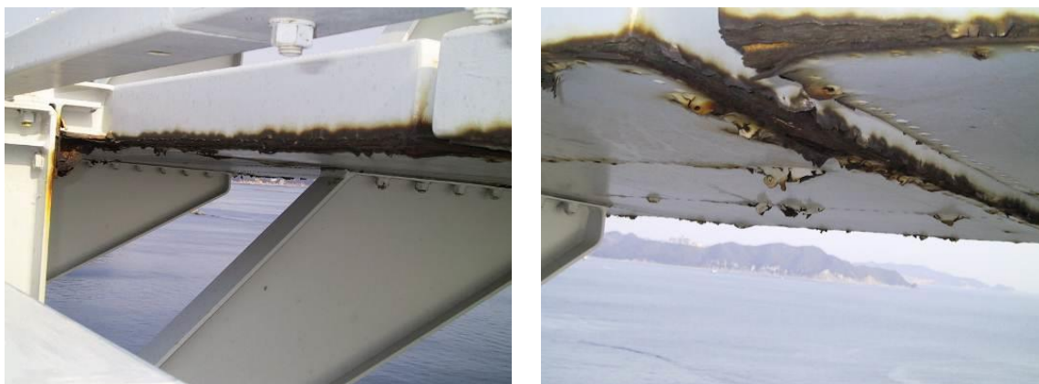
写真- 4.2.1 ダブルフラップの腐食状況
