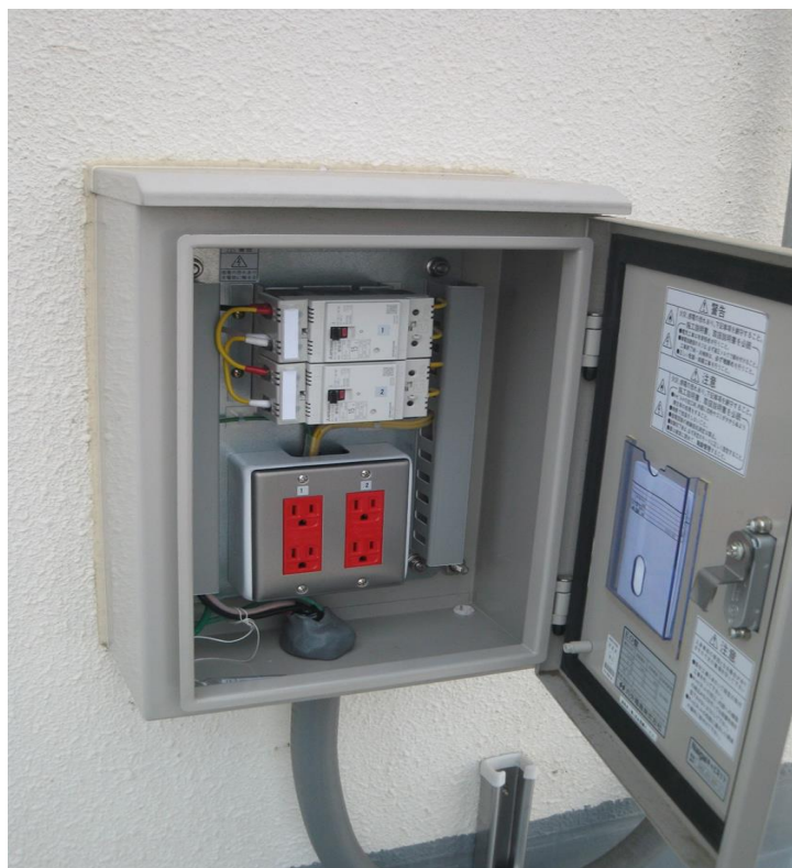
図 4.5 PV 発電専用コンセント盤（横浜市 G 小）
