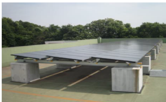
図 4.1 屋上の PV パネルの外観（横浜市 K 小）
